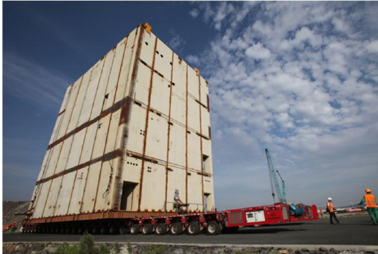
三门核电站一号机组CA20模块运往1号核岛指定起吊位置
