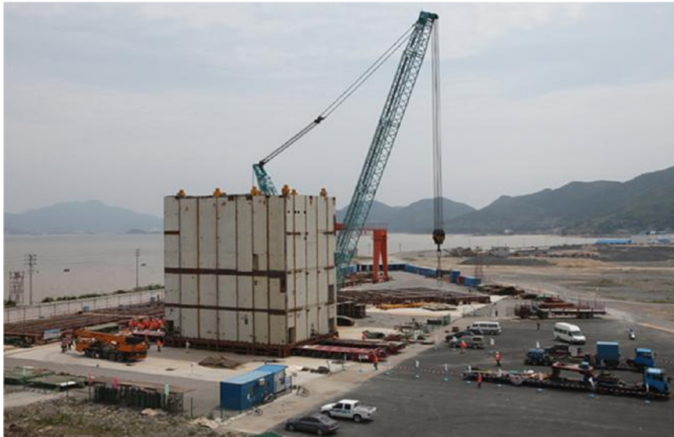
三门核电站一号机组CA20模块从模块拼装场启运
